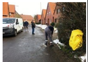
↑ Stromkasten mit Haube abgedeckt
